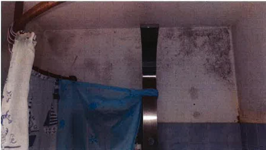
Humidité dans la salle de bain (pas de ventilation ni VMC)
